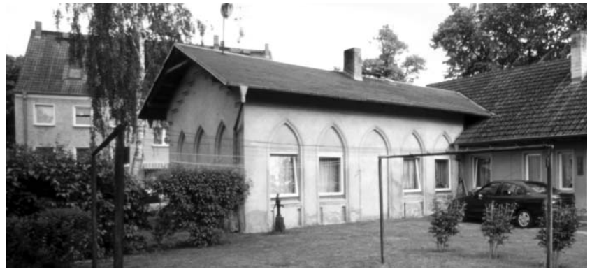
Synagoge Groß Neuendorf (2004). Blick von Norden. Synagoge in Groß Neuendorf (2004).
